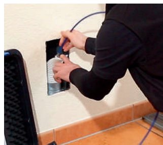
Limpieza de conductos
