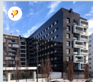
Inspira 53 viviendas Passivhaus
