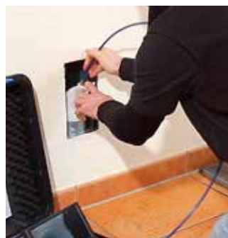
Limpieza de conductos
